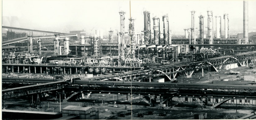
Bild 2: Übersichtsaufnahme von der Rectisolanlage des GKSP. Die Ziffern 1 - 4 kennzeichnen in der Reihenfolge von rechts nach links die vier Stränge der Rectisolanlage. Beim Strang 4 handelt es sich um den havarierten Anlagenteil.
